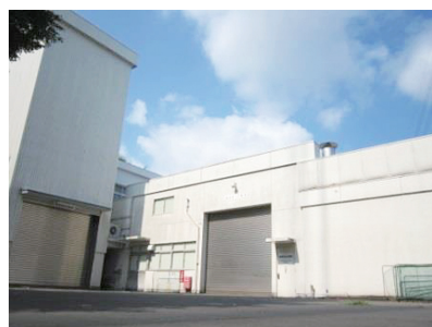
機械総合試験場
