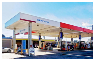
【水素ステーション】
