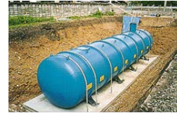
【耐震性貯水槽】
