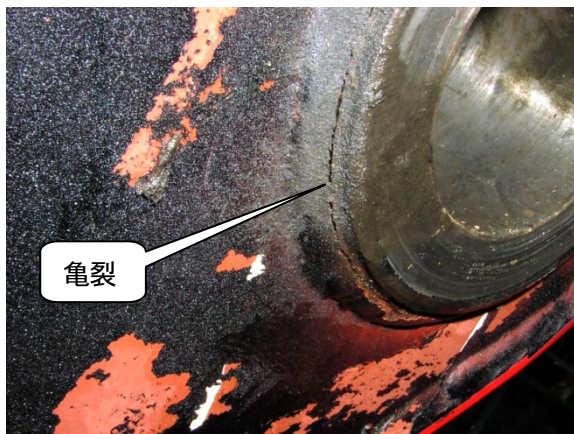
写真3 三角フレーム側
