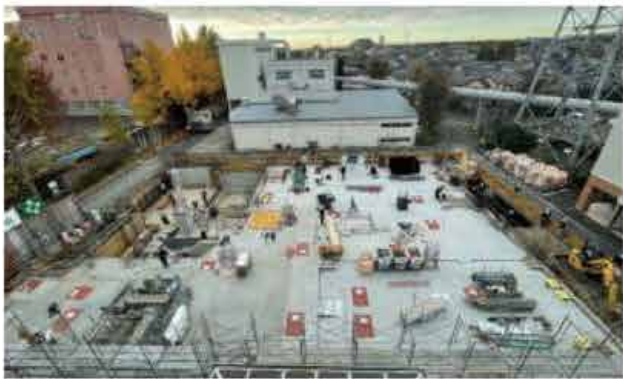
令和5年11月 コンクリート打設（1階）
