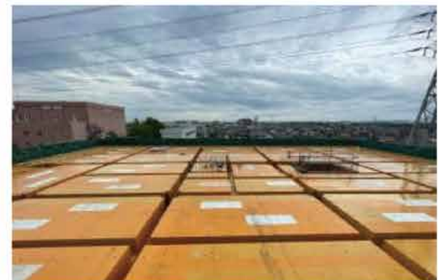
令和6年4月 型枠完了（4階、屋上）
