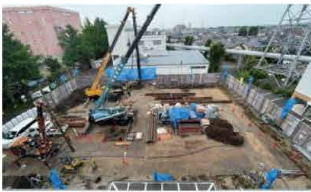
令和5年6月 杭工事・山留工事
