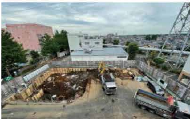
令和5年7月 根伐工事
