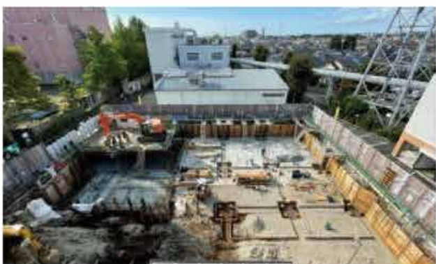
令和5年9月 スラブ配筋（地下部）
