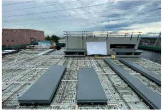
令和6年6月 内装・外装工事
