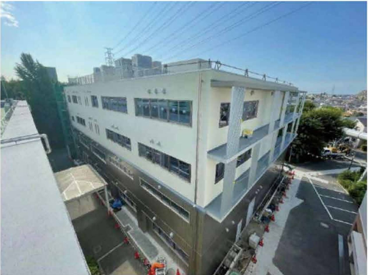
令和6年7月 外部足場解体、内装工事、昇降機工事
