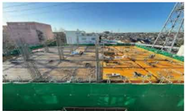
令和6年2月 鉄筋・型枠施工中（3階）
