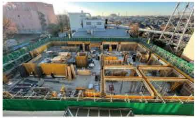
令和5年12月 鉄筋・型枠施工中（1階）
