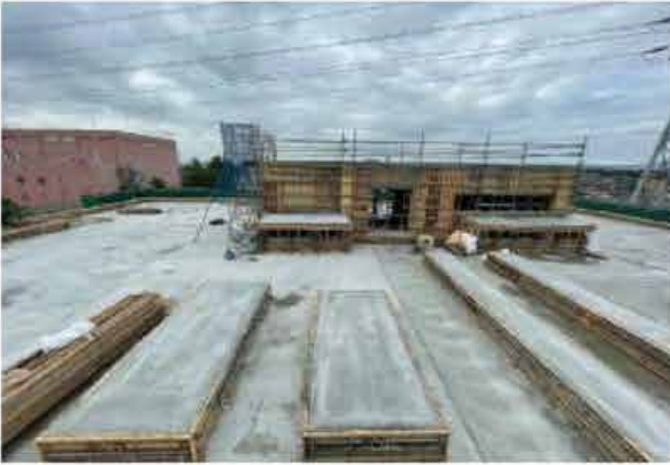
令和6年5月 躯体工事完了
