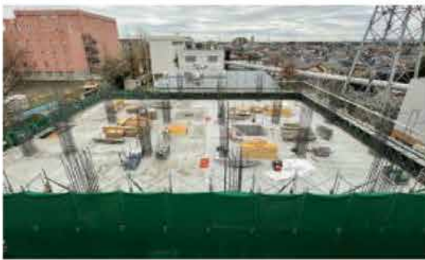
令和6年1月 コンクリート打設（2階）
