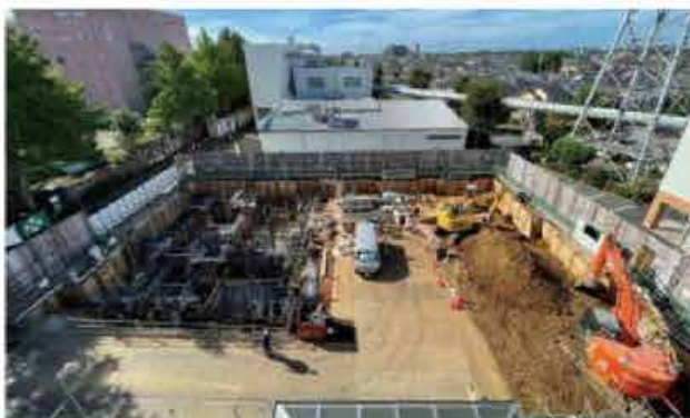
令和5年8月 躯体工事（地下部）
