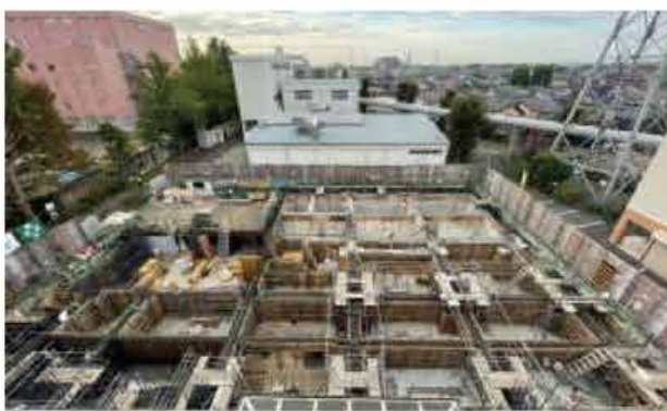
令和5年10月 型枠施工中（1階）
