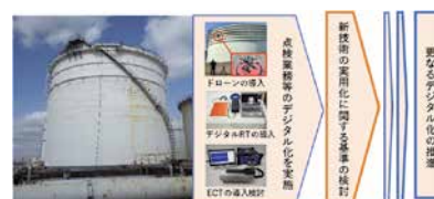
屋外貯蔵タンク
